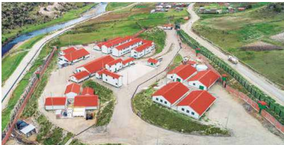
Base Policial de Operaciones Especiales, ubicado en Cotabambas.
