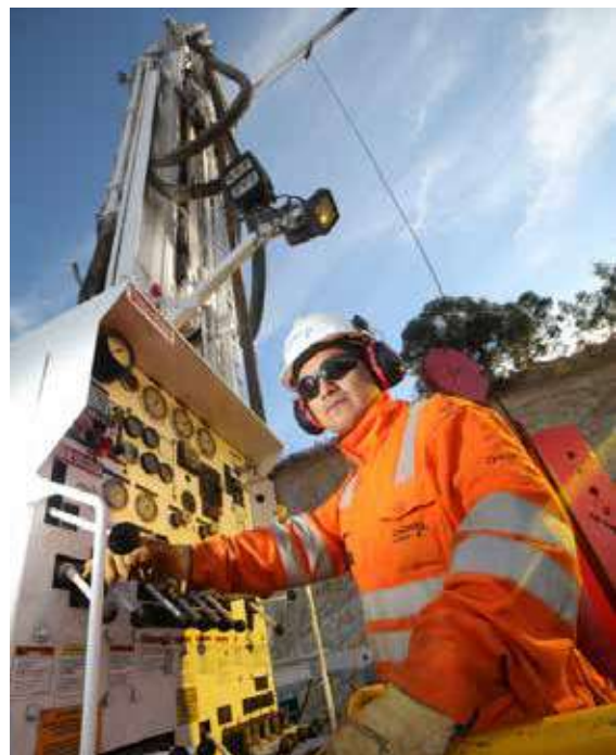
Perforación pozo de agua.
