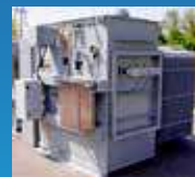
Transformadores del tipo subestación
