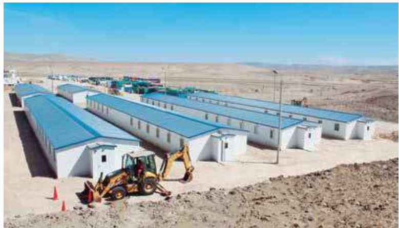
Desde el 2018, Promet se encuentra desarrollando el campamento de operación y construcción de Marcobre, el cual comprende casi 4,000 camas en 13 meses
