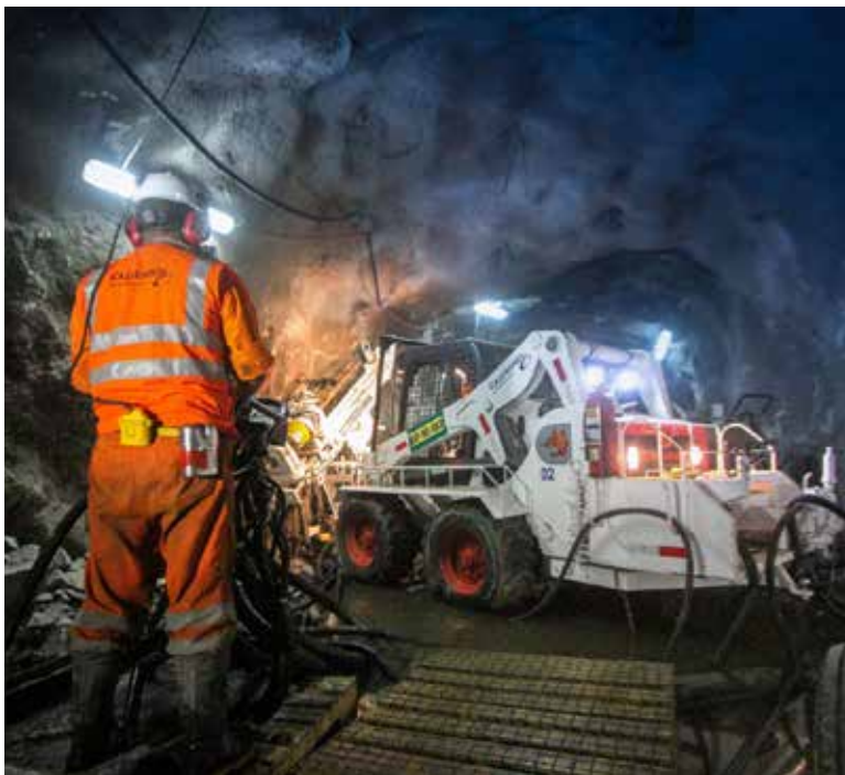
Actividad de perforación diamantina subterránea.
